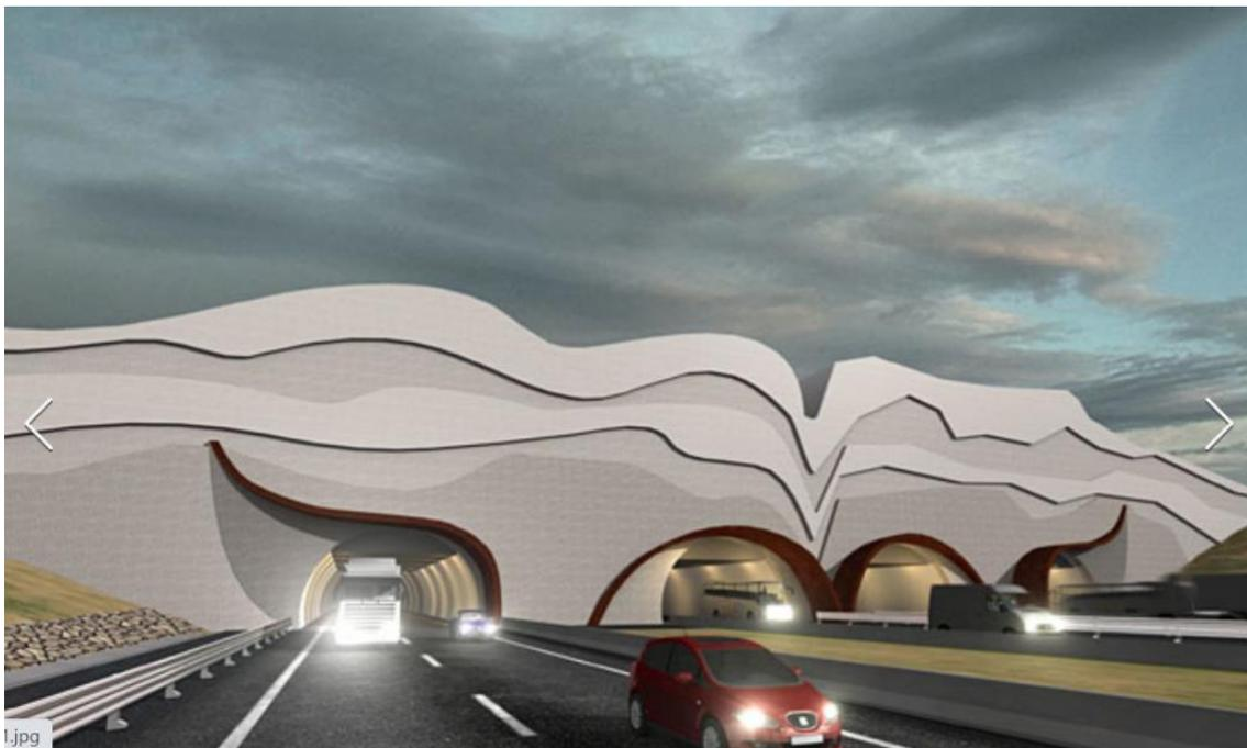
Tras realizar los pertinentes estudios hidráulicos, la distancia adoptada en proyecto como hueco libre entre las motas de protección de los túneles es de 1.850 metros, que se corresponde con una sobreelevación de la lámina de agua estimada de 28 centímetros para la avenida de 8.700 m<sup>3</sup>/segundo de periodo de retorno de 500 años, de acuerdo con los modelos realizados con el programa HEC-RAS.
