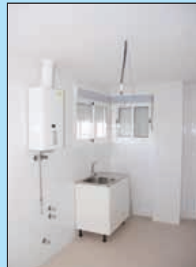
Cocina de las Viviendas
